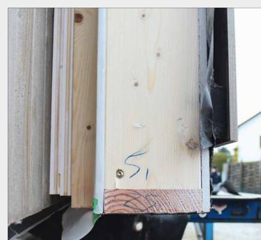
Querschnitt eines Holzelements
