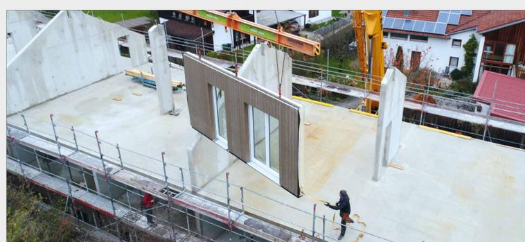
Montage eines Fassadenelements mit Hilfe eines Autokranes
